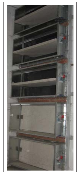
Brandschutzklappen, selbstschließend mit Endschalter.
